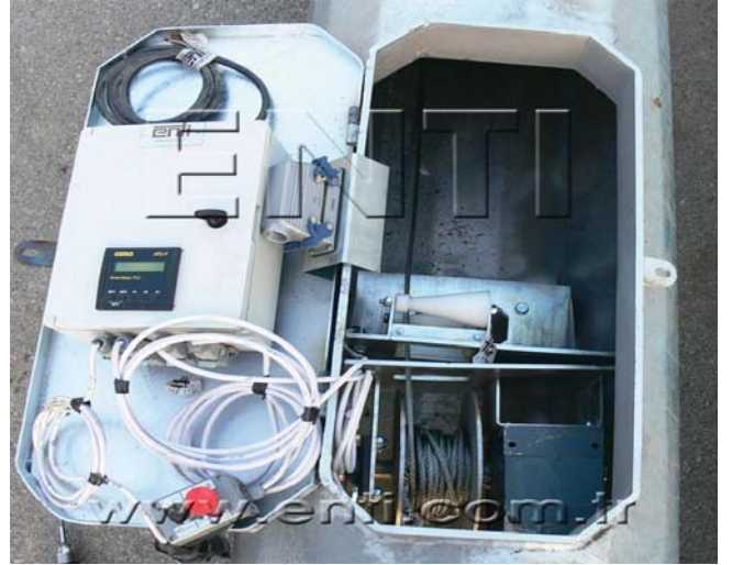
Asansörlü Projektör Direği PLC Pano ve Kumanda
