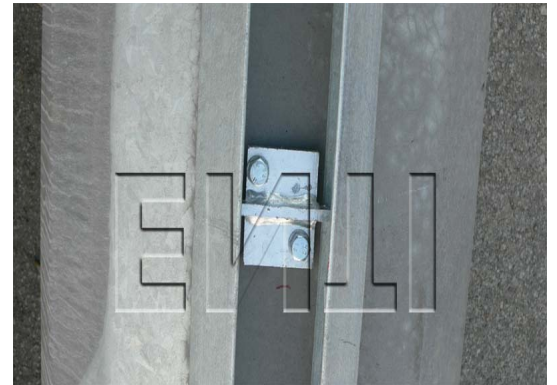
Asansörlü Direk Ray Sistemi Bağlantı
